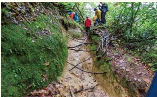
階段設置のための資材を検討しています。 所有者の許可を得て付近の樹林で資材となる木を探し、細い枝で仮置きします。
