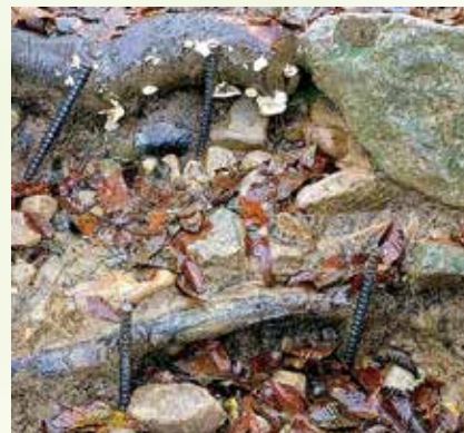
2,000 m付近「従来工法」の階段 いつか崩壊して鉄筋が残ることになります。
