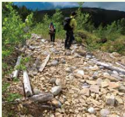
2,000 m付近「従来工法」の階段 いつか崩壊して鉄筋が残ることになります。
