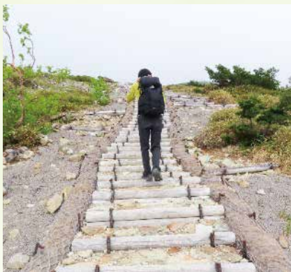
2,000 m付近「従来工法」の階段 いつか崩壊して鉄筋が残ることになります。
