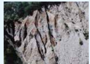
鬼が城崩壊地
