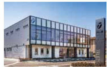
屋上の太陽光パネルにより、自家発電。 シンプルなカーテンウォールが特徴。
